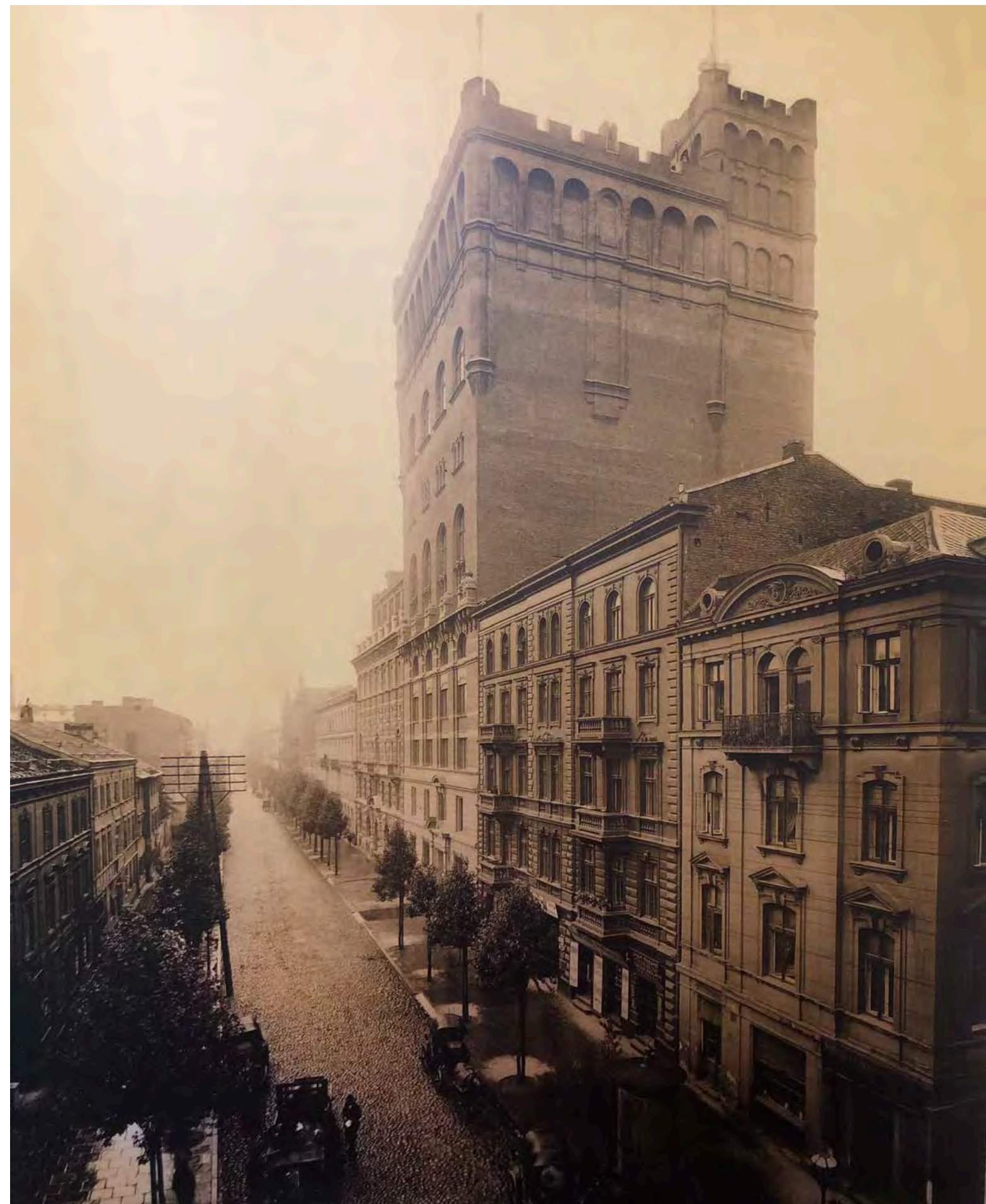
Budynek PAST-y i ulica Zielna w latach 20. fot. archiwum firmy Ericsson
