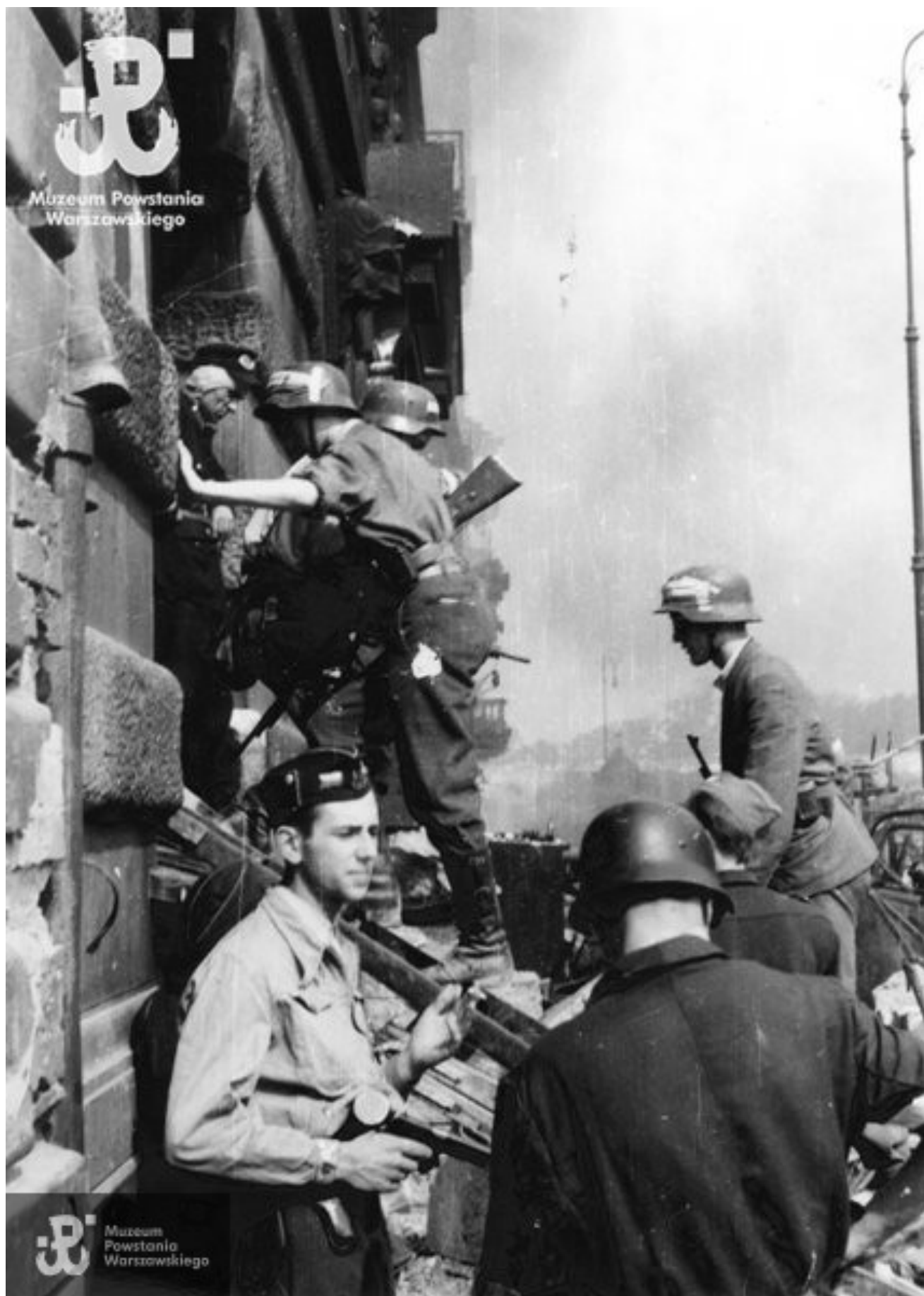
Powstańcy z batalionu „Kiliński” wchodzący do budynków PAST-y przy ulicy Zielnej 37/39
