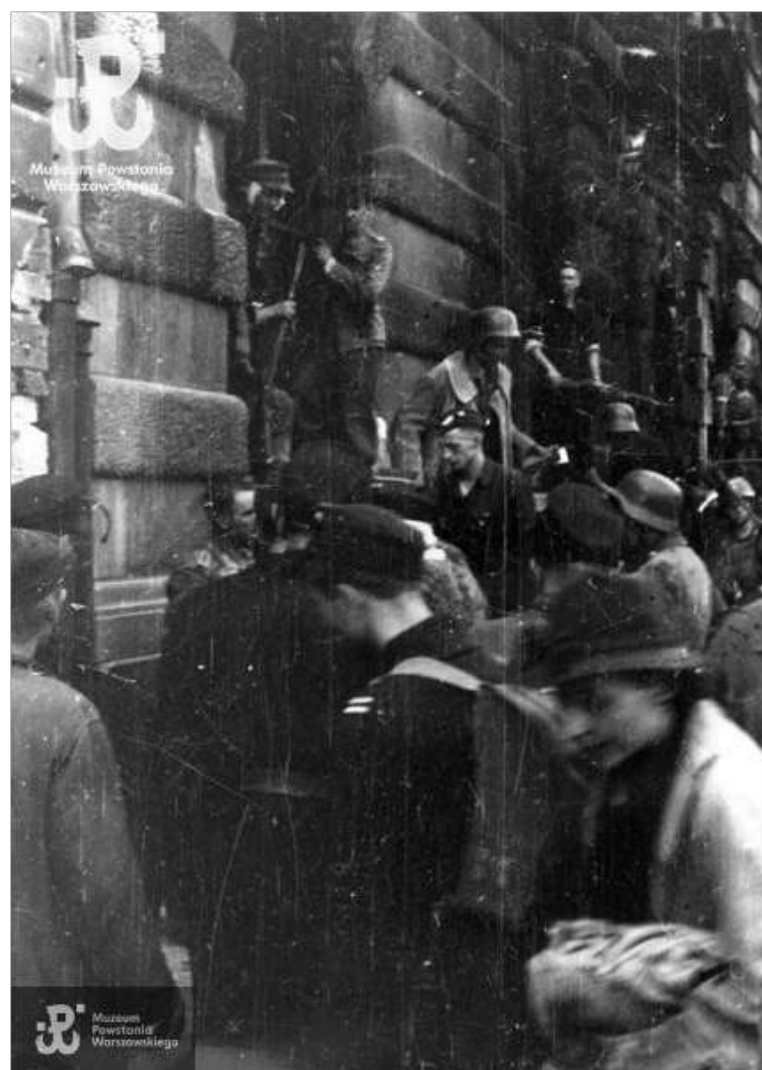
Powstańcy z batalionu "Kiliński" wyprowadzają jeńców z budynków PAST-y fot. Eugeniusz Lokajski „Brok”
